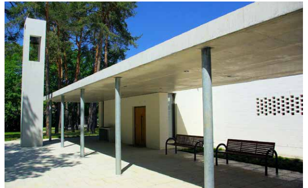
Harmonischer Gesamteindruck an einem Ort der Stille: die sanierte Aussegnungshalle des Gemeindefriedhofs Feucht.
