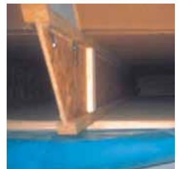
Blick in eine Dachkonstruktion aus I-Profilen mit 40 cm Dämmdicke
