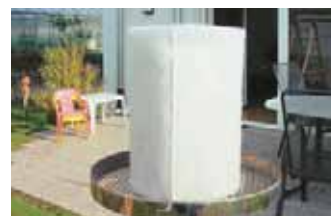
Außenluftansaugung mit Filter
