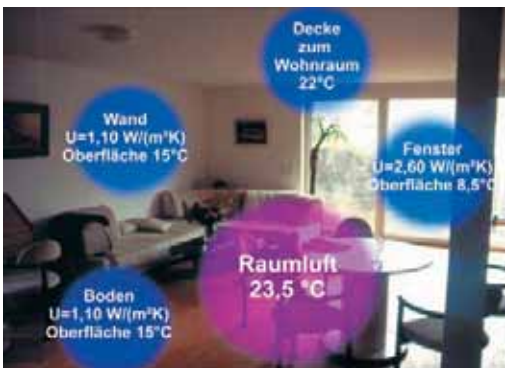
Temperaturen bei einem Gebäude mit schlechter Dämmung (bei Außentemperatur -10^\circ\text{C} )
