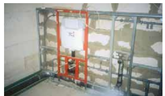
Luftdichtes Verspachteln hinter der Vorwandinstallation
