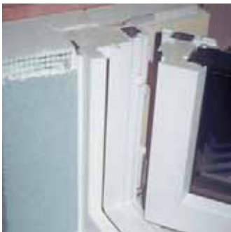
Wärmebrückenarme Einbausituation eines passivhaustauglichen Kunststofffensters
