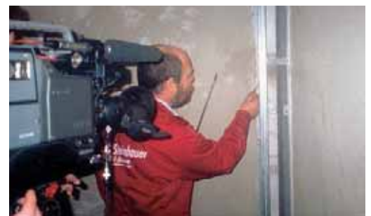
Überprüfung einer Außenwand auf Luftdichtheit an einer Anschlussstelle
