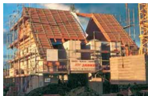
Vorgefertigte Holzkonstruktion mit Holz-I-Profilen
