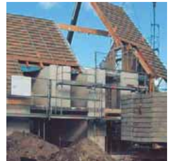
Dachkonstruktion für ein Passivhaus aus vorgefertigten Holzelementen mit I-Profilen
