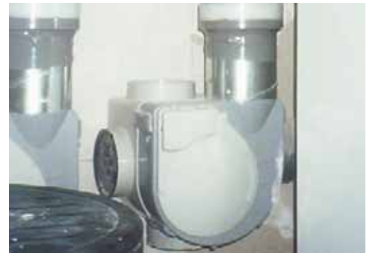
Ventilatorbox und Schalldämpfer einer kontrollierten Lüftungsanlage
