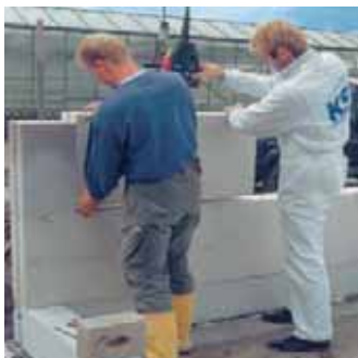
Mauerwerk mit porosierter unterster Lage zur Wärmebrückenreduktion
