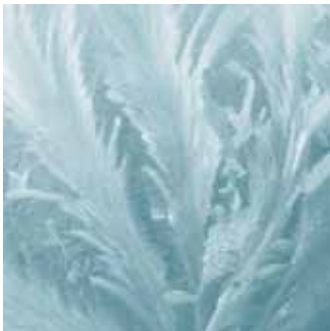
Einscheibenverglasung bei innerer Oberflächentemperatur unter dem Gefrierpunkt
